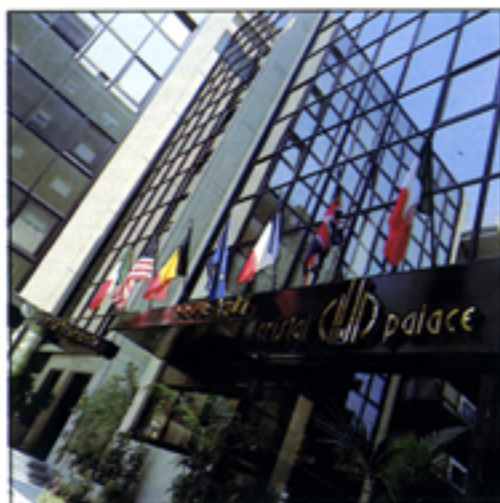
Il modernissimo esterno del Cristal Palace, che sorge nel centro della cittadina pugliese è dotato di 40 camere, cinque suite, un ristorante e un centro sportivo.
